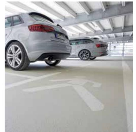
Insgesamt wurden über 50.000 Quadratmeter Bodenfläche mit dem Oberflächenbeschichtungssystem Deck OS 8 beschichtet.
