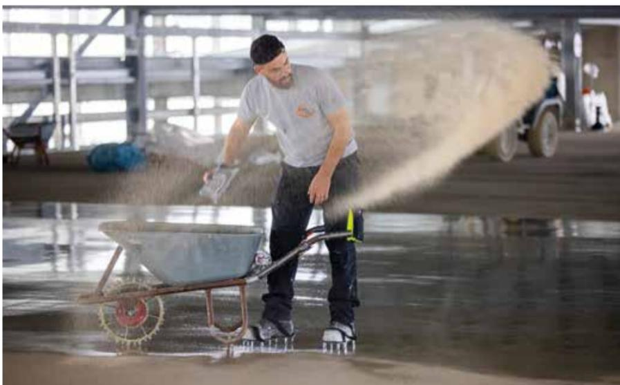
Vollsatt und gleichmäßig wurde die feuergetrocknete Quarzsandmischung Quarz 03/08 DF im Überfluss eingestreut.
