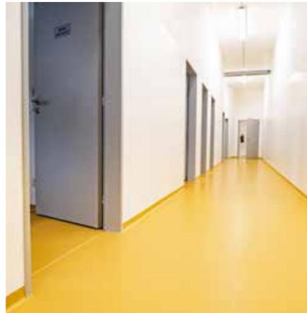
Flure und Umkleiden im Gebäude wurden ebenfalls mit der belastungsfähigen Bodenbeschichtung versehen.
