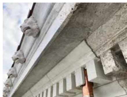
Blick auf das Tempelgesims West nach Instandsetzung des Betonwerksteins und Restaurierung des Natursteins.
